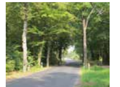
Auch die Arbeiten an der Kamenzer Straße konnten begonnen werden.
