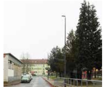
Beleuchtung an der A.-Schweitzer-Str. nachher
