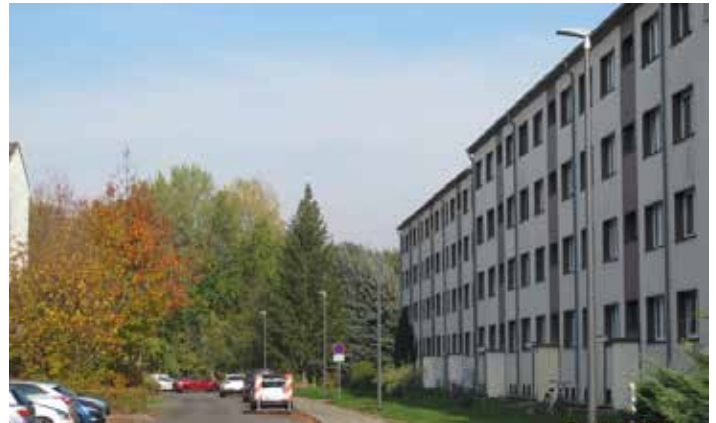
neue Beleuchtung an der A.-Schweitzer-Str.
