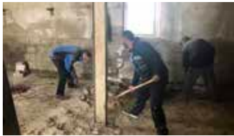
Entkernen des alten Feuerwehr-Gerätehauses
