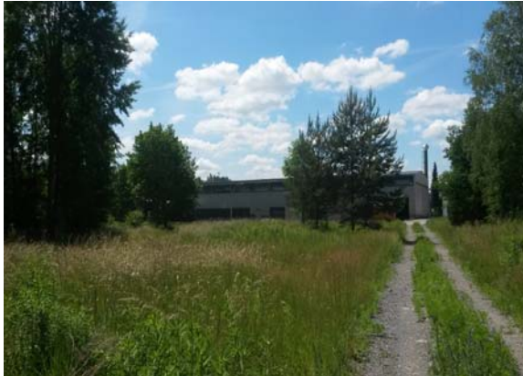
Gras- und Krautflur mit Gehölzaufwuchs und verdichtete Zufahrt
